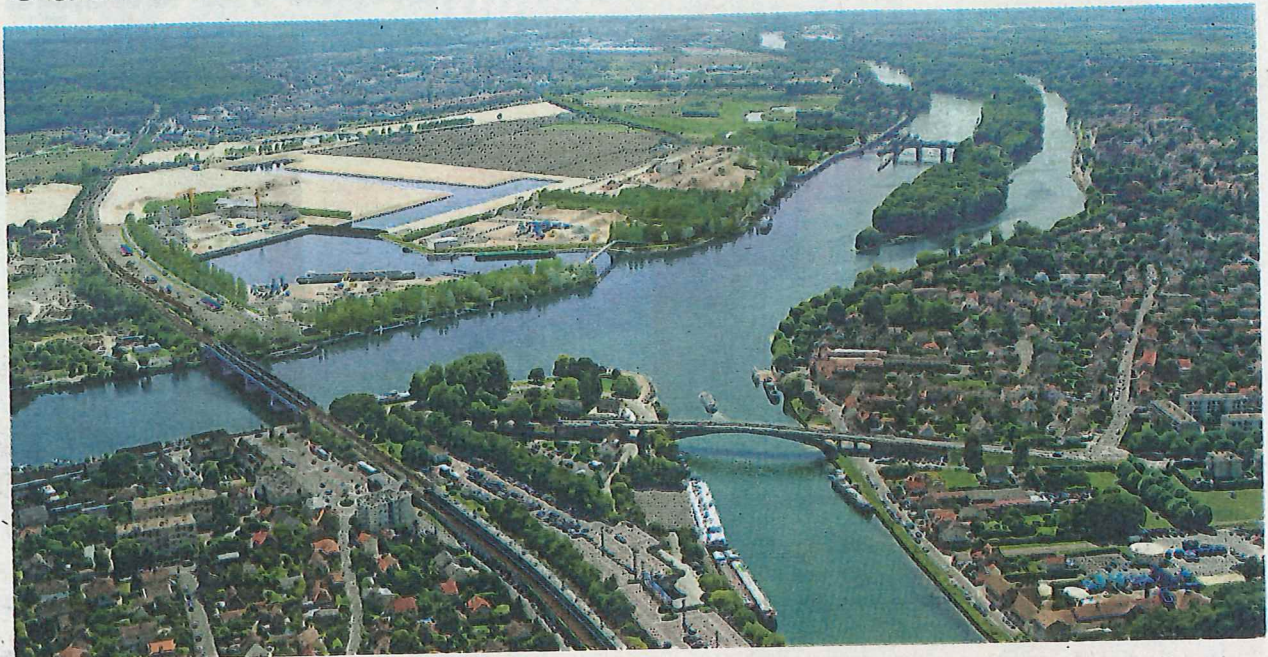
Les travaux préparatoires du projet de plateforme multimodale d'environ 100 ha ont débuté le 22 janvier sur la berge du quai de l'île du Bac, à Achères, avec l'abattage d'arbres et le défrichage de la végétation. © Gerard Halary / Haropa
